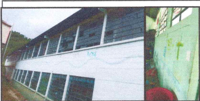
FOTO 5. Pintura en muros exteriores e interiores
