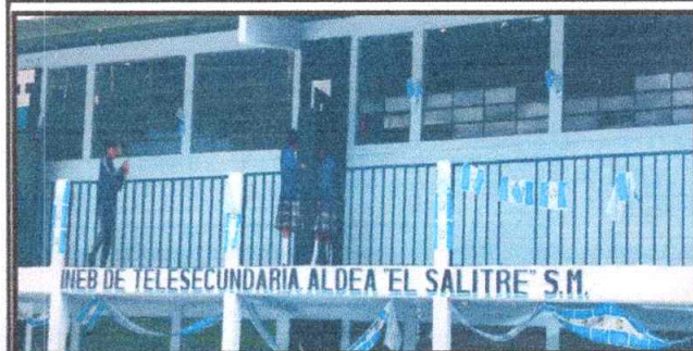
FOTO 6. Mantenimiento a barandas de metal
