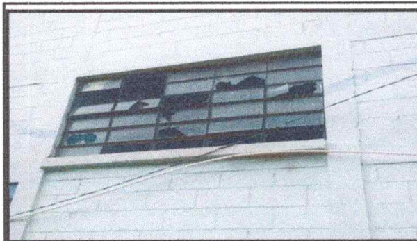
FOTO 4. Sustrucción de vidrios 0.45 mts. X 0.20 mts.
